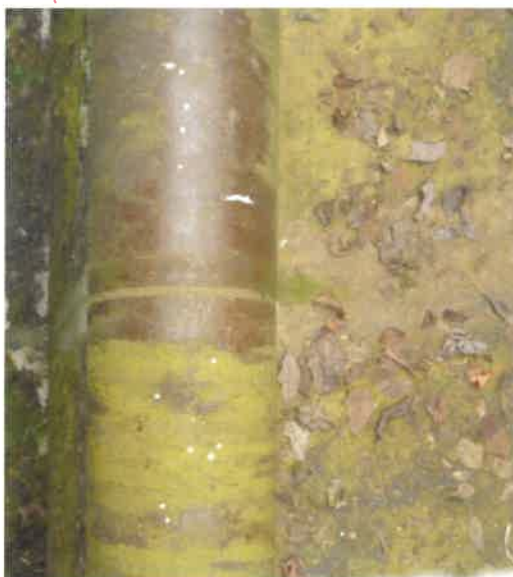
Abbildung 1: Überlaufwehr im Regenüberlauf VHRÜB45
