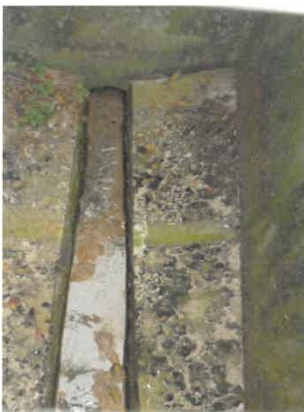
Abbildung 2: Zulaufkanal des Regenüberlaufs VHRÜB45
